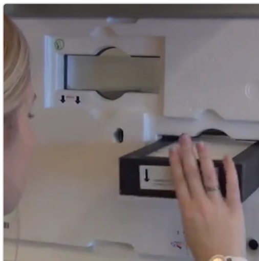
Sådan udskiftes filteret i Dantherm Home-ventilationsenheder
